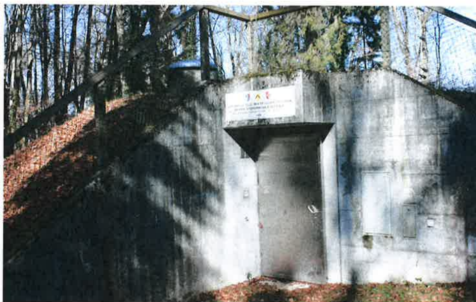
Station de pompage de l'EIEVMV
