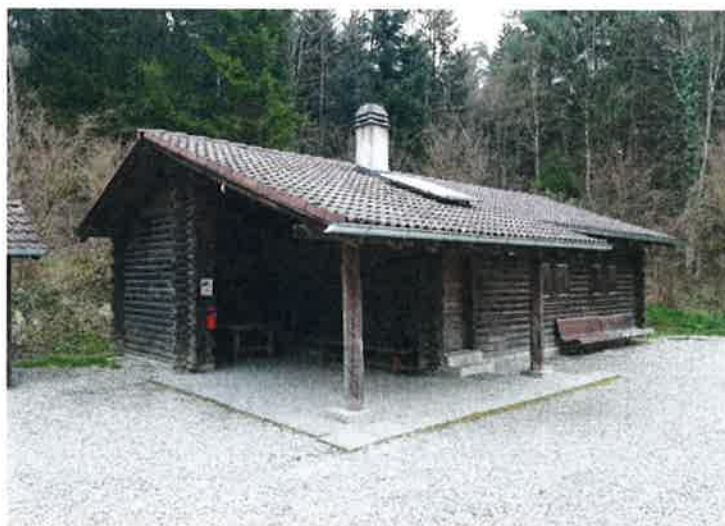
Notre refuge avant la rénovation
