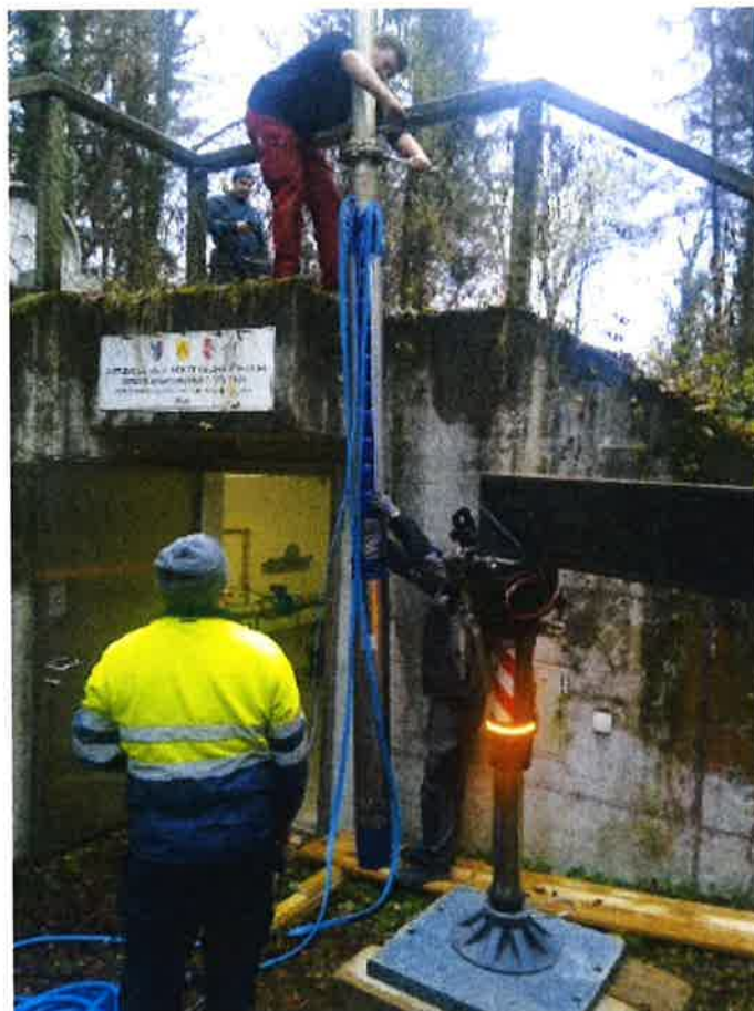
Remplacement de la pompe EIEVMV
