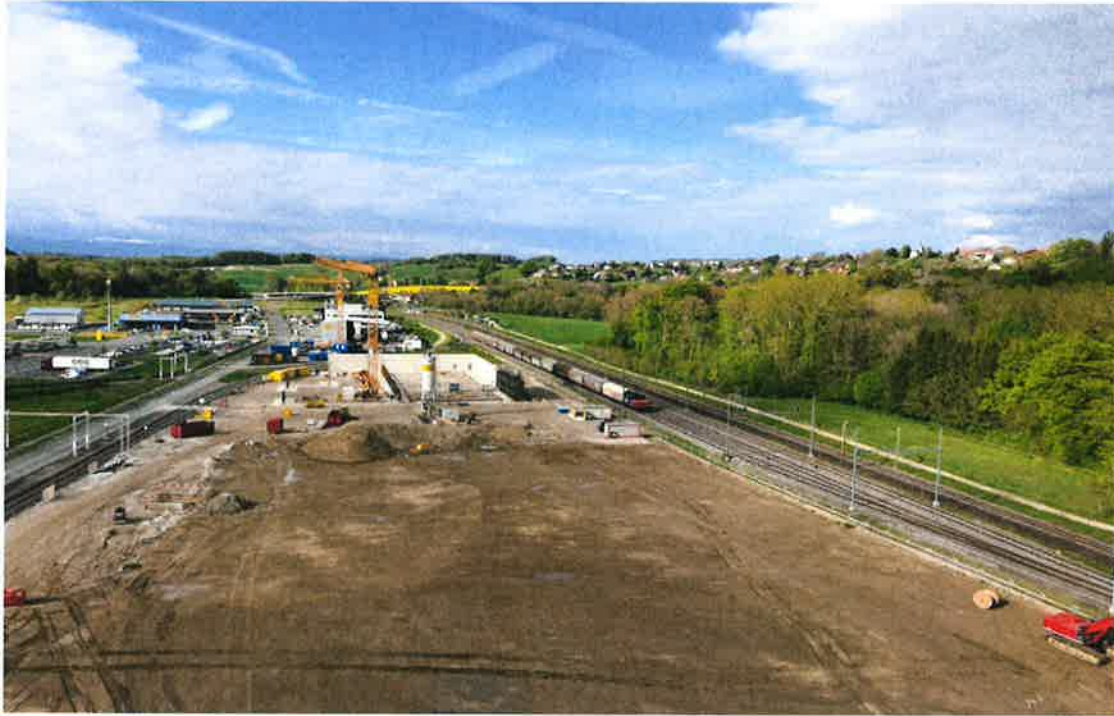
Photo prise depuis une grue par Valérie Jacquemettaz – SecuChantier Sàrl
