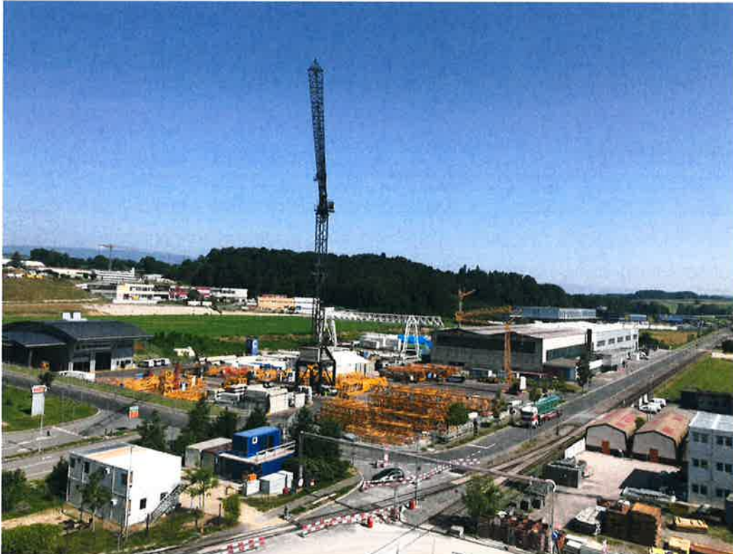
Photo prise depuis une grue par Valérie Jacquemettaz – SecuChantier Sàrl
