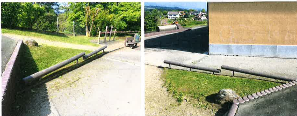
Mur trop proche de la poutrelle
