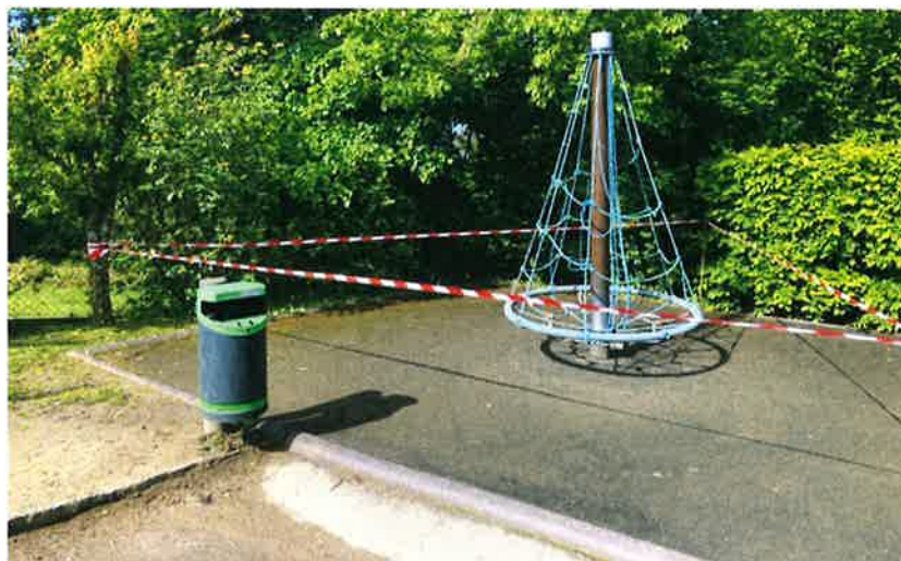
Tour grimpante rotative avec poubelle trop proche
