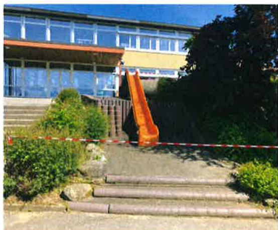
Vue générale du toboggan et sa sortie
